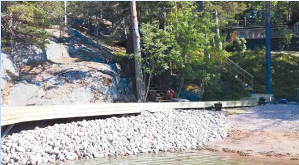
Rannan muokkaus: kivetys ja hiekkaranta sekä kiinteä kulkusilta laiturille
