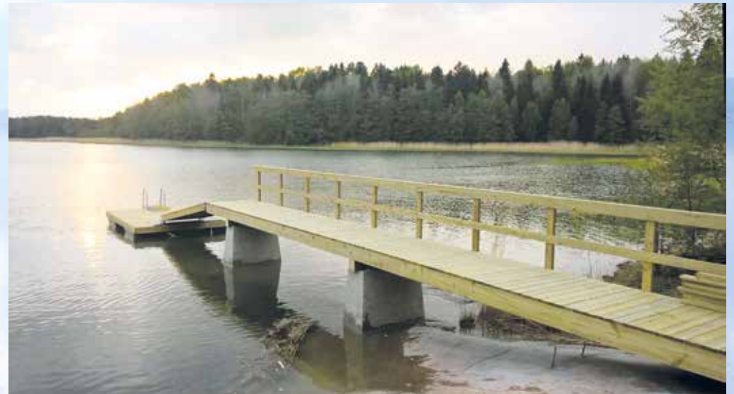
Matalassa kalliorannassa valetut betonimaatuet
